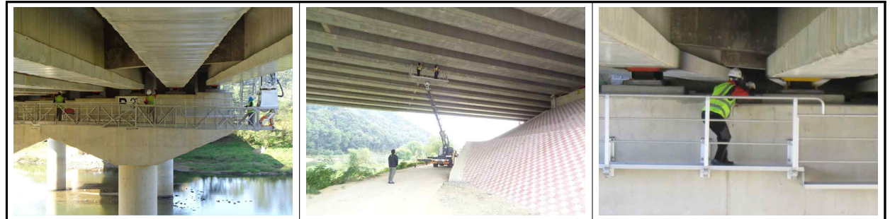
[고소작업차, 굴절점검차를 이용한 근접조사 실시]
