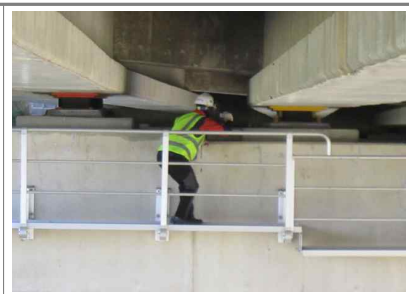
▲ 교량받침 점검로 근접조사
